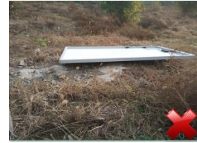
禁止玻璃面/背板直接 接触地面
